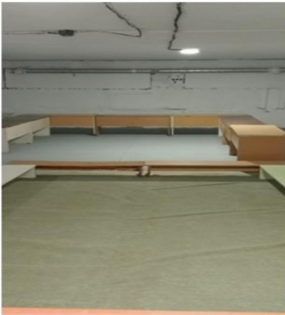
Заклад дошкільної освіти №11 (улаштування стяжки)
