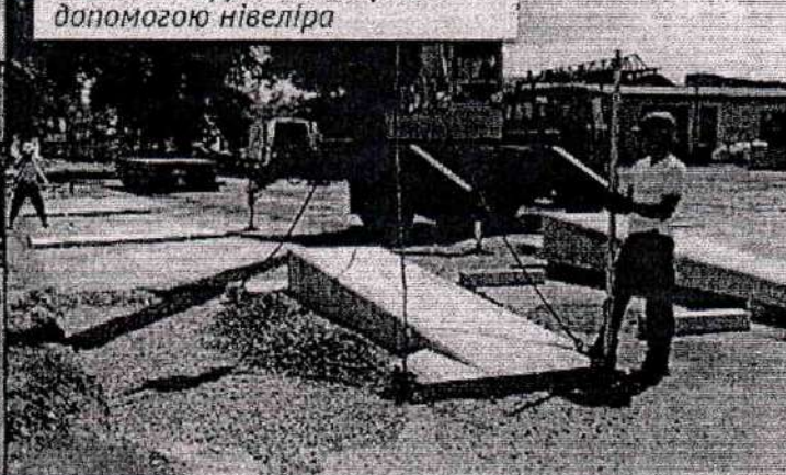
4. Вирівнювання кожного елемента фундаменту за допомогою нівеліра
