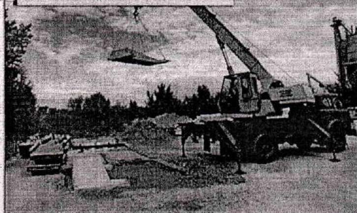
3. Встановлення готового фундаменту
